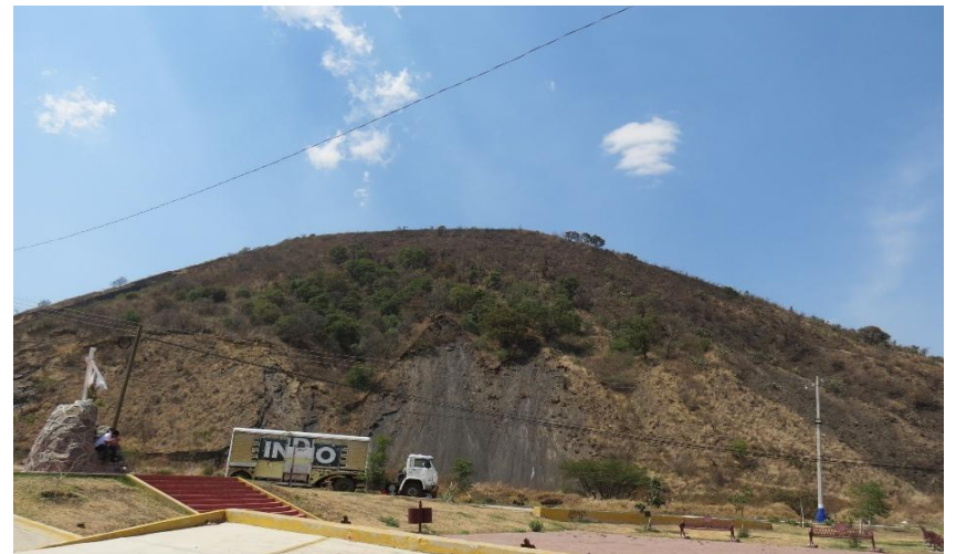
(IMAGEN 143) Fuente: Coordinación de Protección Civil y Bomberos 2025
