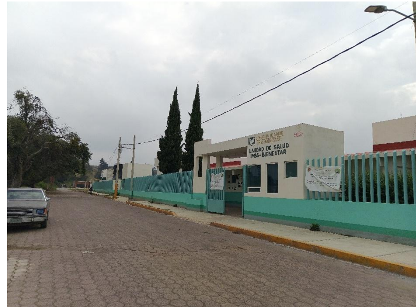
(IMAGEN 91) Fuente: Coordinación de Protección Civil y Bomberos 2025.
