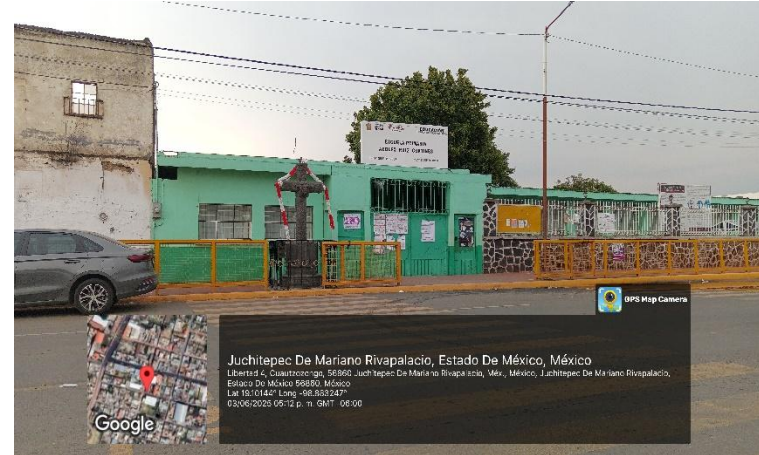
(IMAGEN 104) Fuente: Coordinación de Protección Civil y Bomberos 2025.
