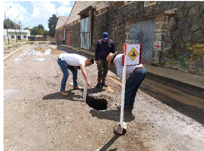
(IMAGEN 160) Fuente: Coordinación de Protección Civil y Bomberos 2025.
