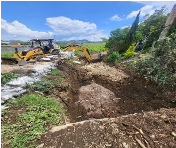
(IMAGEN 219) Fuente: Coordinación de Protección Civil y Bomberos 2025
