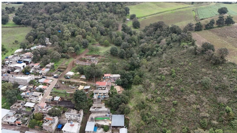
DT-17 LOCALIZACIÓN DE TIRADERO DE BASURA CLANDESTINO SOBRE GRIETA CON DESLIZAMIENTO DE TIERRA (IMAGEN 127) Fuente: Coordinación de Protección Civil y Bomberos 2025
