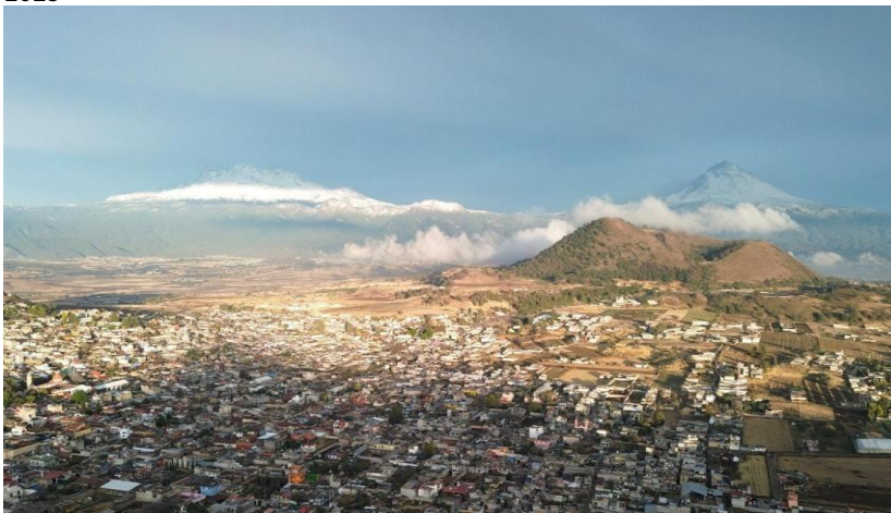
CABECERA MUNICIPAL (IMAGEN 156) Fuente: Coordinación de Protección Civil y Bomberos 2025
