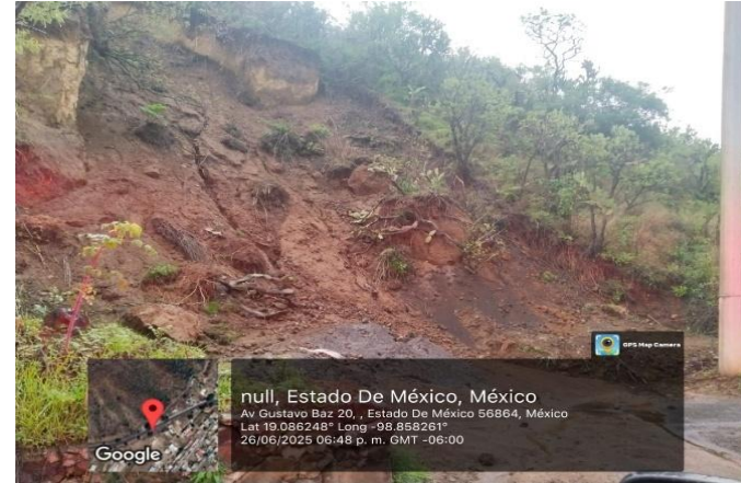
(IMAGEN 146) Fuente: Coordinación de Protección Civil y Bomberos 2025
