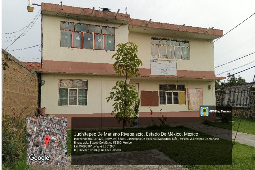
(IMAGEN 101) Fuente: Coordinación de Protección Civil y Bomberos 2025.
