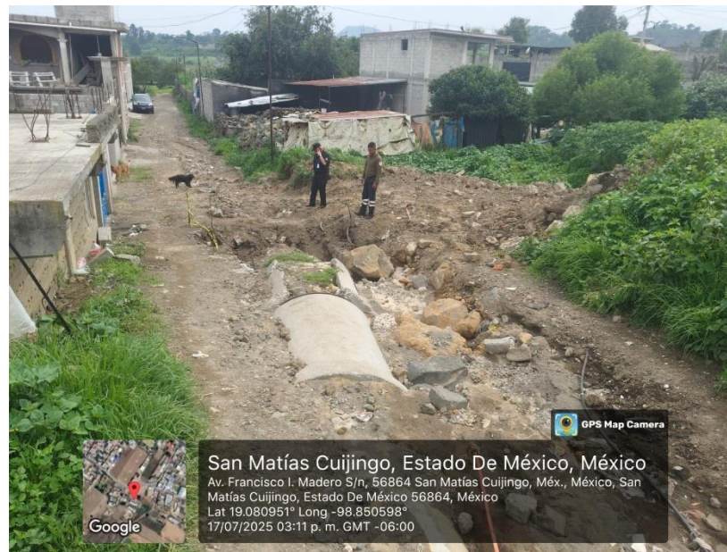
(IMAGEN 223) Fuente: Coordinación de Protección Civil y Bomberos 2025
