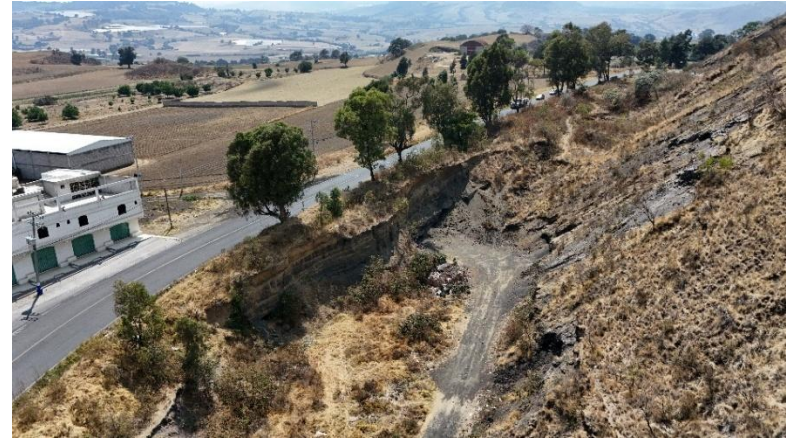
EXTRACCIÓN DE TIERRA HACIA TRAMO CARRETERO CON RIESGO DE HUNDIMIENTO (IMAGEN 125) Fuente: Coordinación de Protección Civil y Bomberos 2025
