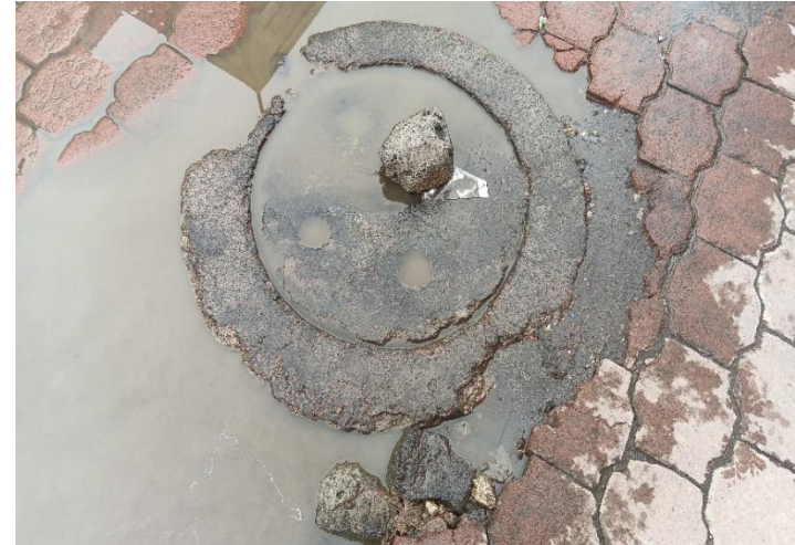
(IMAGEN 171) Fuente: Coordinación de Protección Civil y Bomberos 2025
