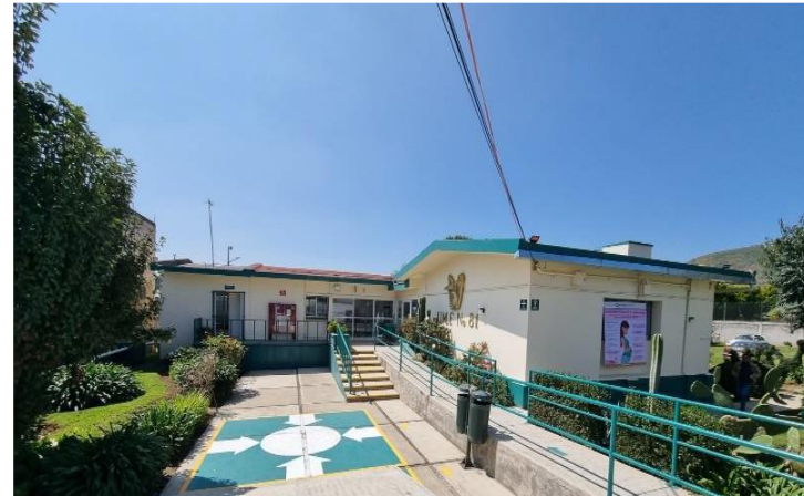
(IMAGEN 89) Fuente: Coordinación de Protección Civil y Bomberos 2025.
