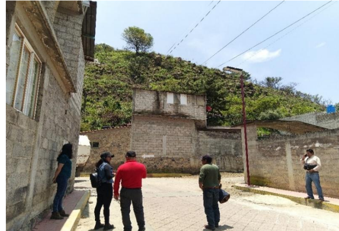
ZONA DE ALTO RIESGO POR DESLIZAMIENTO DE TIERRA Y PIEDRAS VULNERABILIDAD DE VIVIENDAS CIRCUNDANTES (IMAGEN 132) Fuente: Coordinación de Protección Civil y Bomberos 2025
