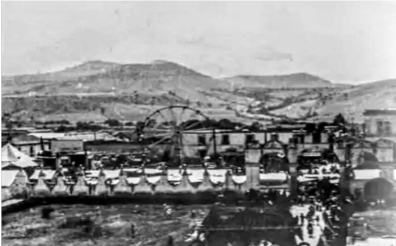
ZONA CENTRO DE JUCHITEPEC (IMAGEN 113) Fuente: Coordinación de Protección Civil y Bomberos 2025
