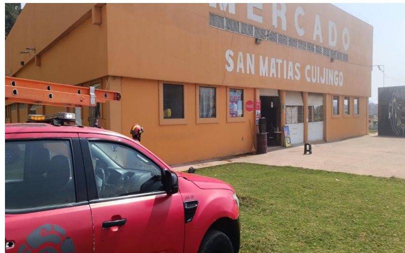
Recorrido parte externa de Mercado Cuijingo IMAGEN (75) Fuente: Coordinación de Protección Civil y Bomberos 2025
