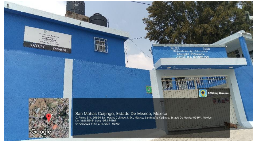
(IMAGEN 99) Fuente: Coordinación de Protección Civil y Bomberos 2025.
