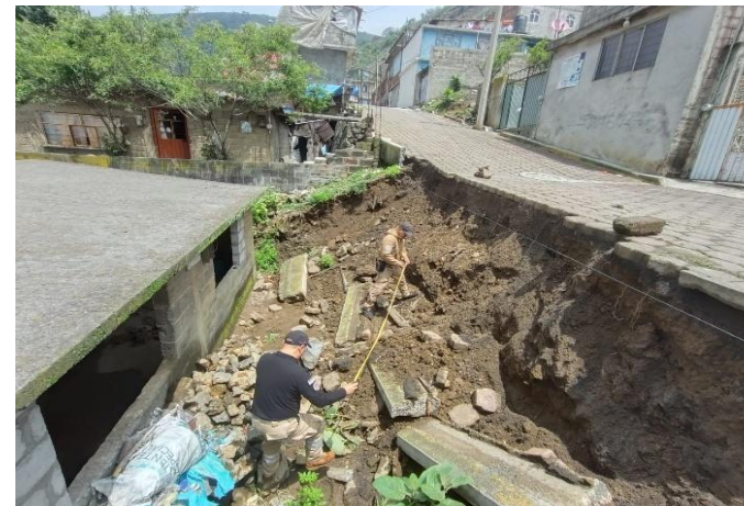
(IMAGEN 147) Fuente: Coordinación de Protección Civil y Bomberos 2025
