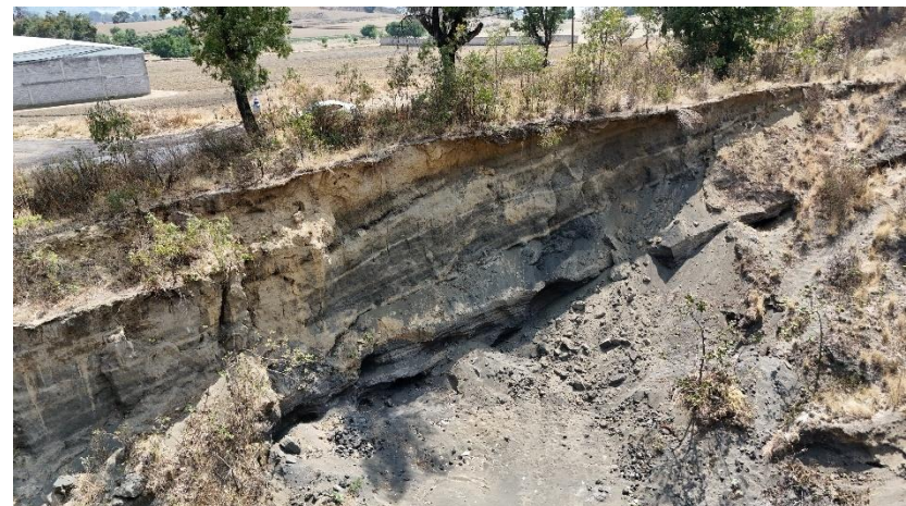
DAÑO ANTROPOGENICO POR EXTRACCIÓN DE ARENA NEGRA SIN VIGILANCIA. REPORTADA A LAS ÁREAS CORRESPONDIENTES DEL AYUNTAMIENTO Y DELEGACION (IMAGEN 126) Fuente: Coordinación de Protección Civil y Bomberos 2025
