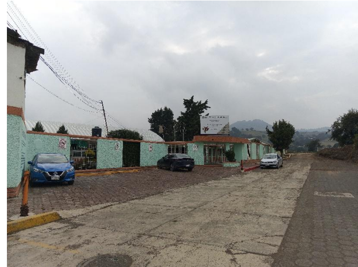
(IMAGEN 103) Fuente: Coordinación de Protección Civil y Bomberos 2025.
