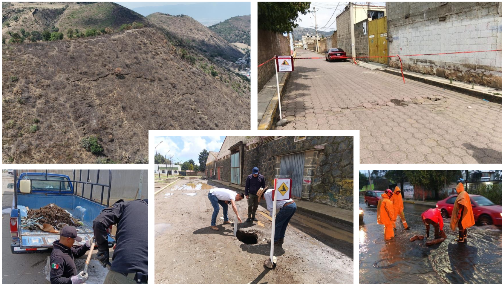
(IMAGEN 203) Fuente: Coordinación de Protección Civil y Bomberos 2025
