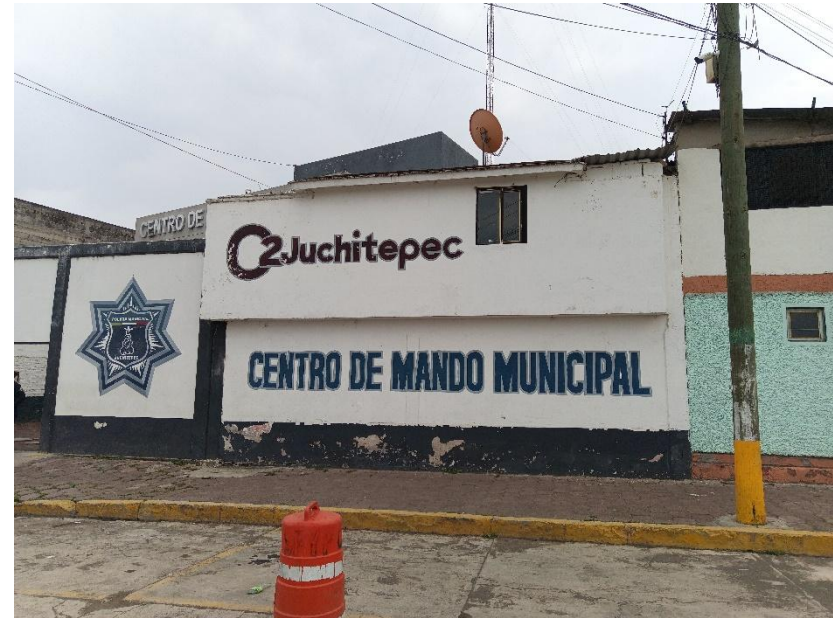
(IMAGEN 93) Fuente: Coordinación de Protección Civil y Bomberos 2025.
