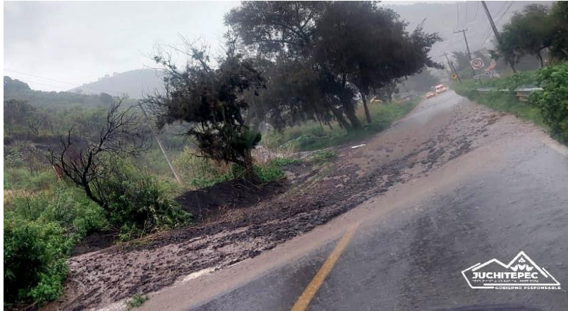
DESPLAZAMIENTO POR AFECTACIÓN PLUVIAL Y FLUVIAL AÑO 2022. (IMAGEN 144) Fuente: Coordinación de Protección Civil y Bomberos 2025
