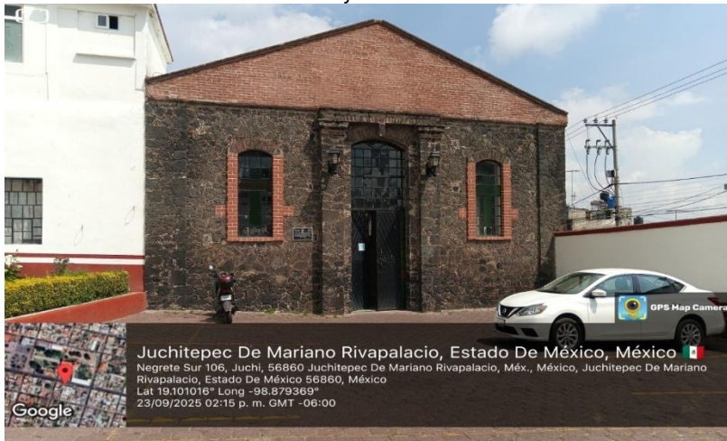
LA OBRA (IMAGEN 107) Fuente: Coordinación de Protección Civil y Bomberos 2025
