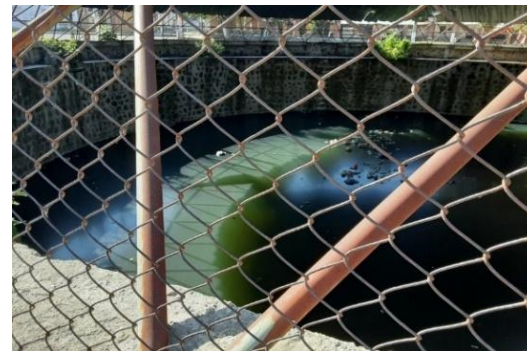
ALGIBE TECHADO (IMAGEN 192) Fuente: Coordinación de Protección Civil y Bomberos 2025.
